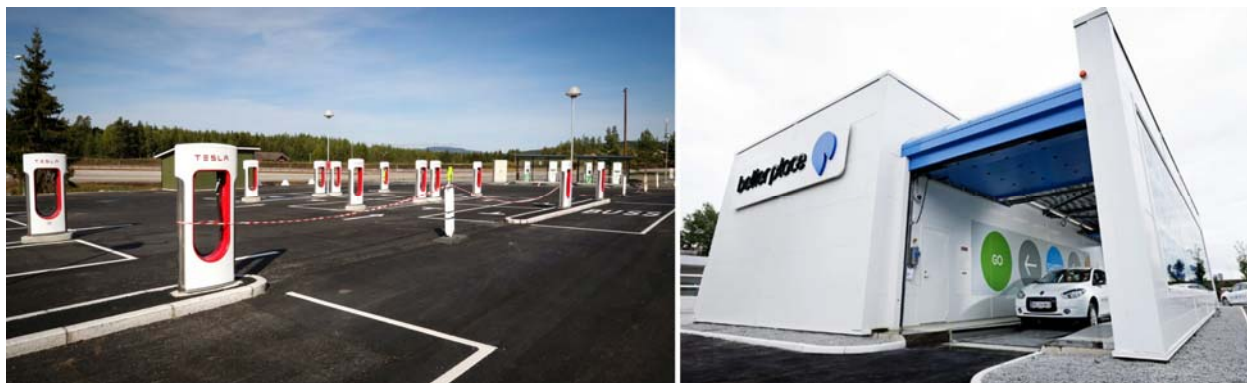
Slika 3. Lijevo: stanica za punjenje, desno: stanica za izmjenu baterija
